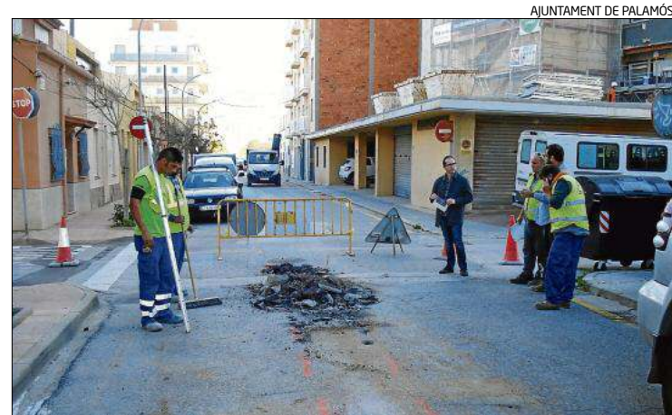
Imatge de les actuacions que es van iniciar ahir al carrer Riera Aubi.
