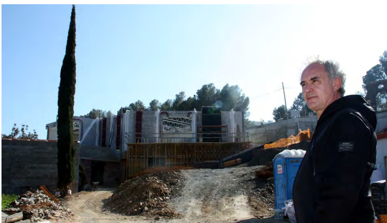
El cuiner, Ferran Adrià, a peu de l'obra que s'està fent a la cala Montjoi de Roses per fer el Bulli 1846. // ACN
