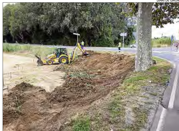
Les màquines que ahir començaven a treballar a la zona.
