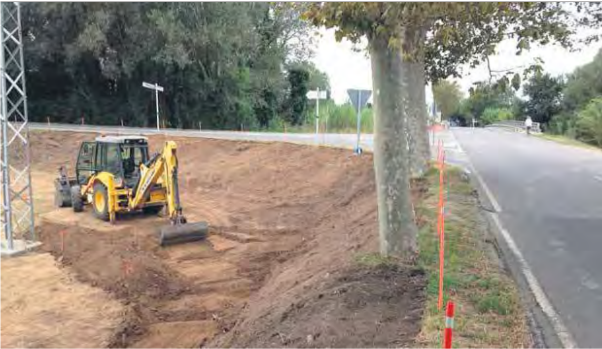
Dos operaris es mantenen a la zona d'obres al migdia, un d'ells dins la màquina ■ JOAN PUNTÍ
