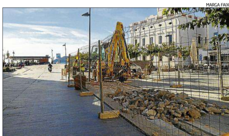
Les màquines treballant en la perforació del sòl a Ses Herbes.
