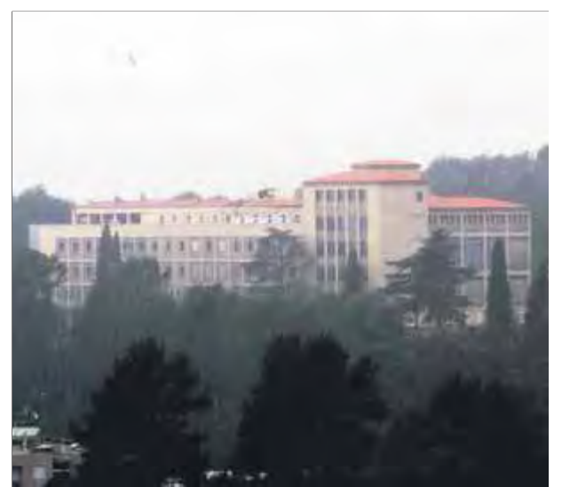
Les instal·lacions on va tenir lloc l'incident ■ MANEL LLADÓ
