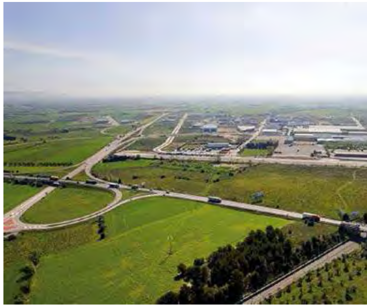
AL FAR D'EMPORDÀ. Vista aèria de la plataforma logística Logis Empordà
