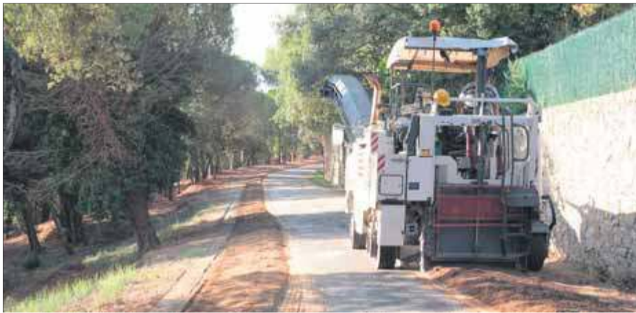
La màquina que aixeca el paviment malmès, ahir al matí, a l'extrem del vial a Romanyà ■ E.A.
