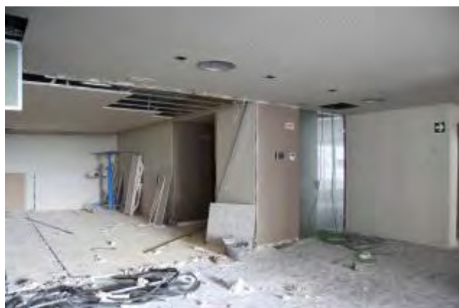
La planta baixa en obres. AR
