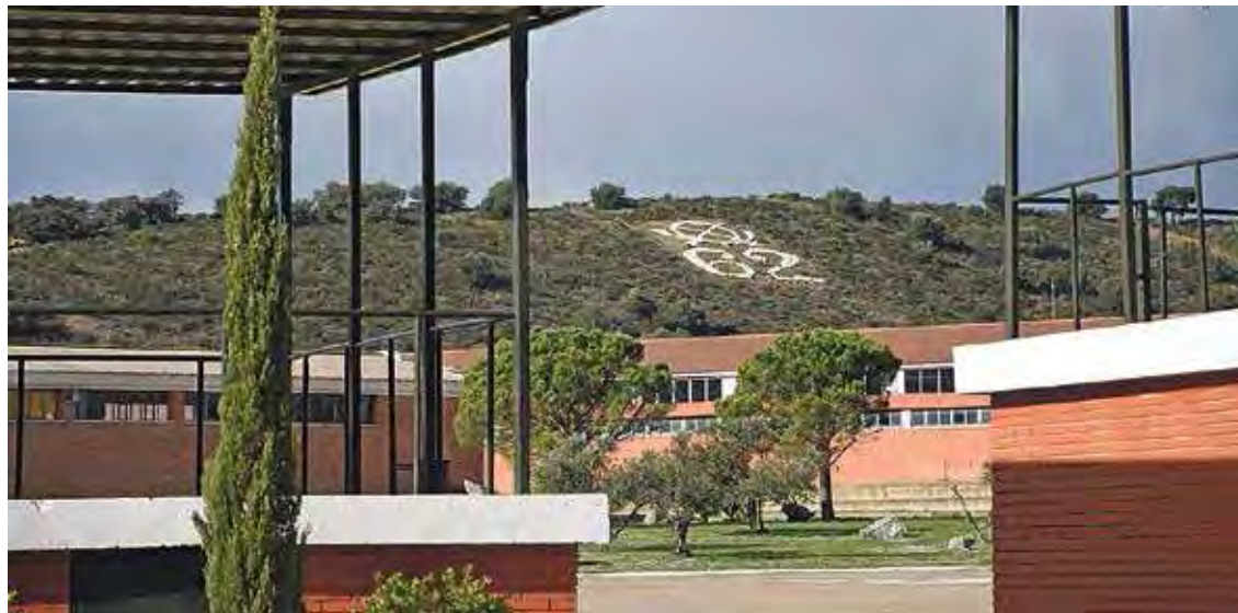
SEU DE L'ARAPILES 62. La base té una extensió de 31 ha dividides en diversos edificis i equipaments
