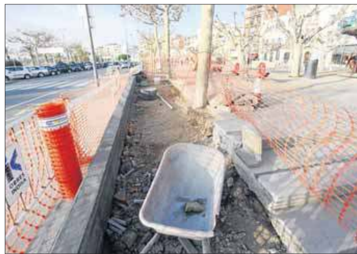
L'entorn de la plaça Catalunya està en obres. ROSANA VIDAL
