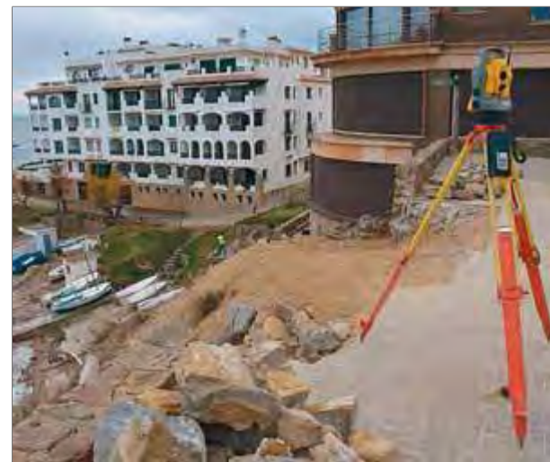
Obres iniciades aquesta setmana a l'Escala per millorar l'accés entre la Creu i el Pedró ■ EL PUNT AVUI
