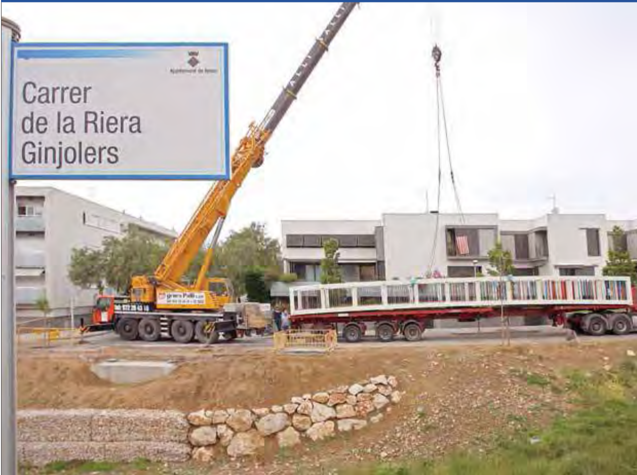
La grua, en un intent fallit d'aixecar la passera sobre la riera Ginjolers de Roses, ahir al matí ■ LLUÍS SERRAT
