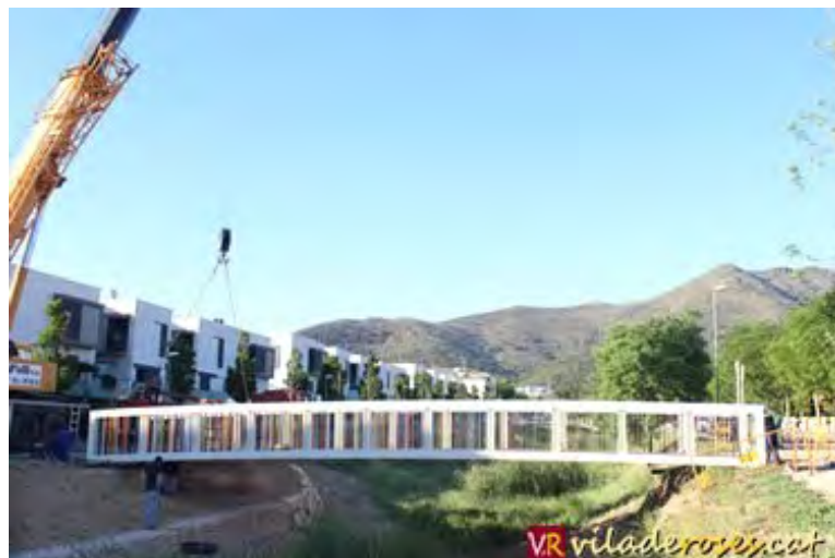
Nou pont de vianants instal·lat a la Riera Ginjolers de Roses
