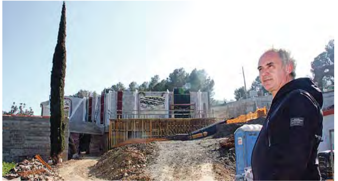
A CALA MONTJOI. L'ampliació del 20% de l'antic restaurant enfila la recta final però el projecte exterior s'ha de refer
