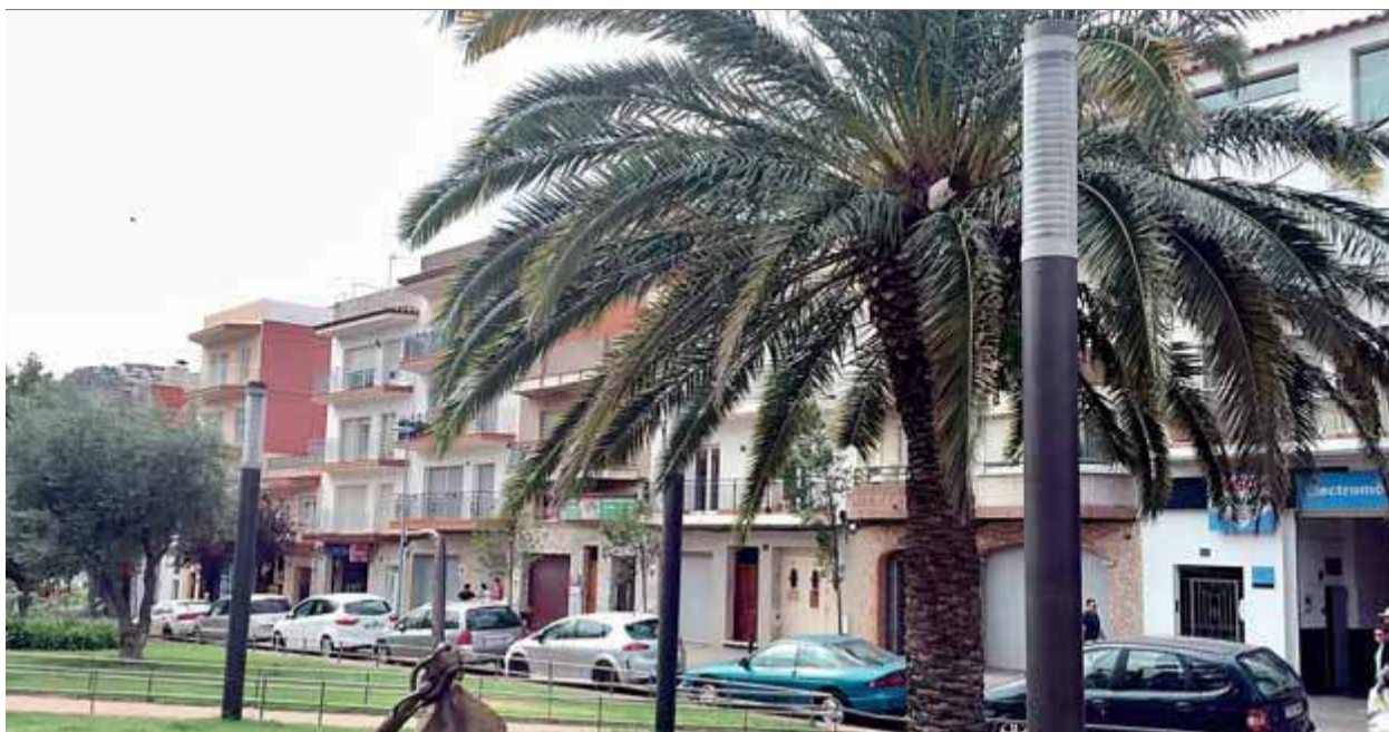
La nova il·luminació ja està instal·lada a la plaça del Rei de Roses ■ EL PUNT AVUI
