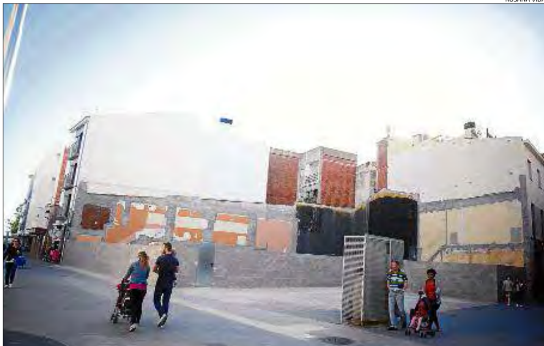
La sala SUF, completament enderrocada a la riera Ginjolers i a punt de començar les obres.
