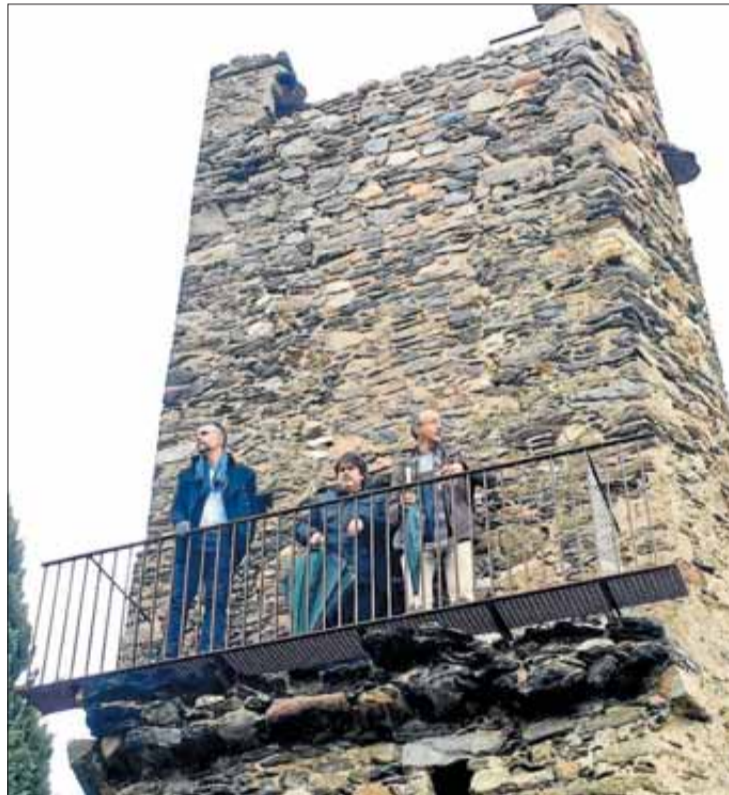
La Torre Medieval està completament consolidada. GENERALITAT DE CATALUNYA
