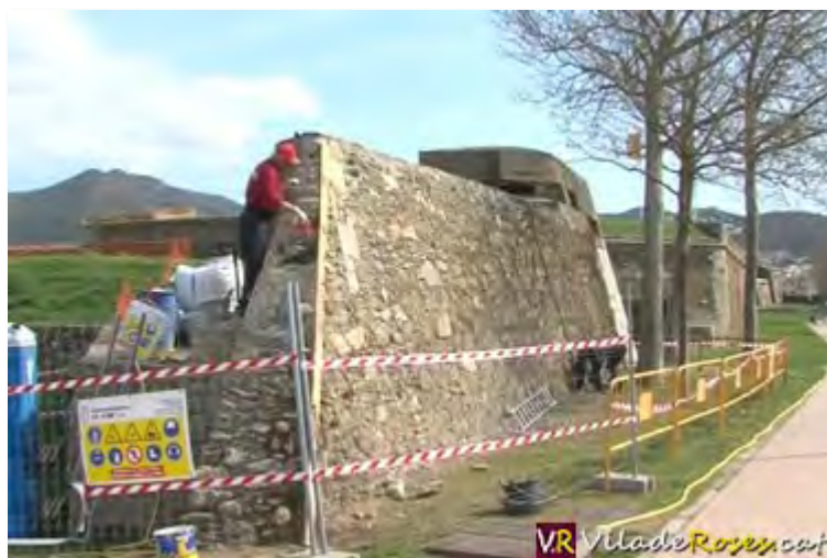
Obres de millora a la muralla de Ponent de la Ciutadella
