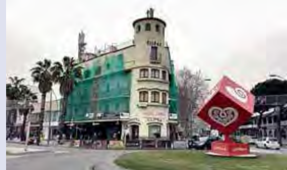
Els treballs de rehabilitació ja són visibles ■ J. TRILLAS
