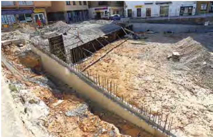
L'ACTUACIÓ. Sota les obres hi quedarà la caseta de salvament marítim ■ BASILI GIRONÈS
