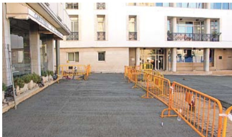
PRIMERA CAPA DE PAVIMENT. L'espai tindrà un sol nivell
