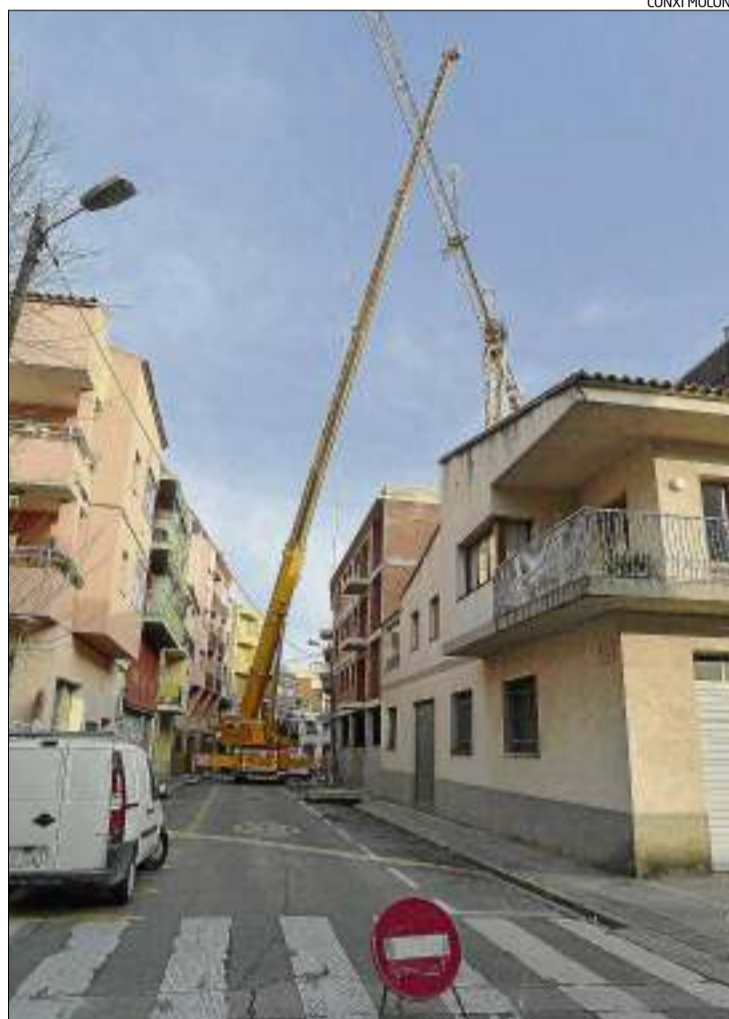
Una grua desmuntant l'altra grua de l'edifici ahir al matí.
