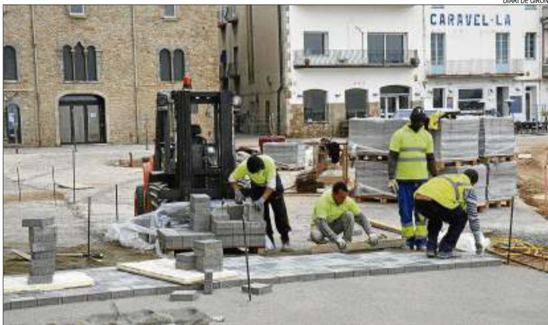
Els operaris treballant en la col·locació del nou paviment de la Platja.
