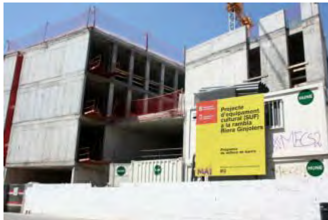
L'edifici que s'està construint ACN
