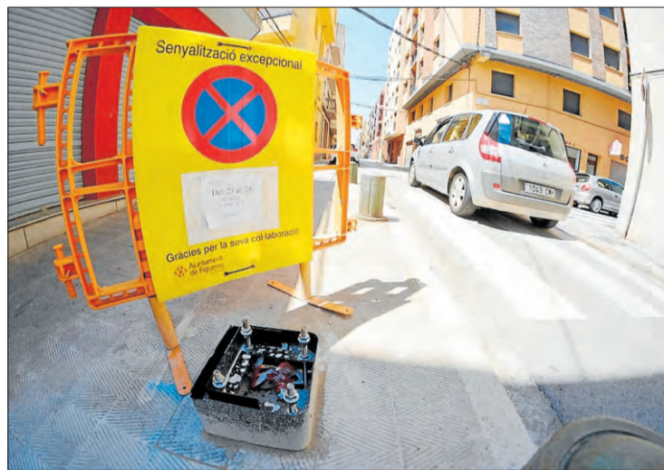
Els treballs per instal·lar els parquímetres AGENCIAS
