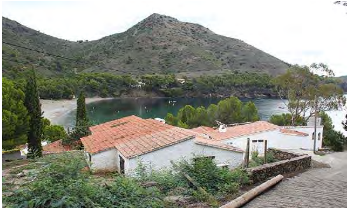
CALA MONTJOI. Les màquines entraran a treballar al febrer per construir el 20% d'ampliació que la llei actual permet
