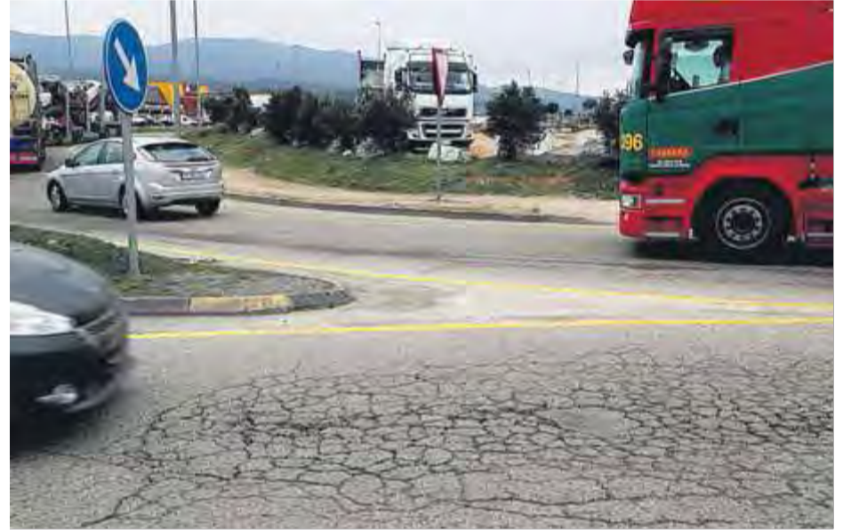
Una de les rotondes en les quals s'ha de rehabilitar el ferm ■ MANEL LLADÓ
