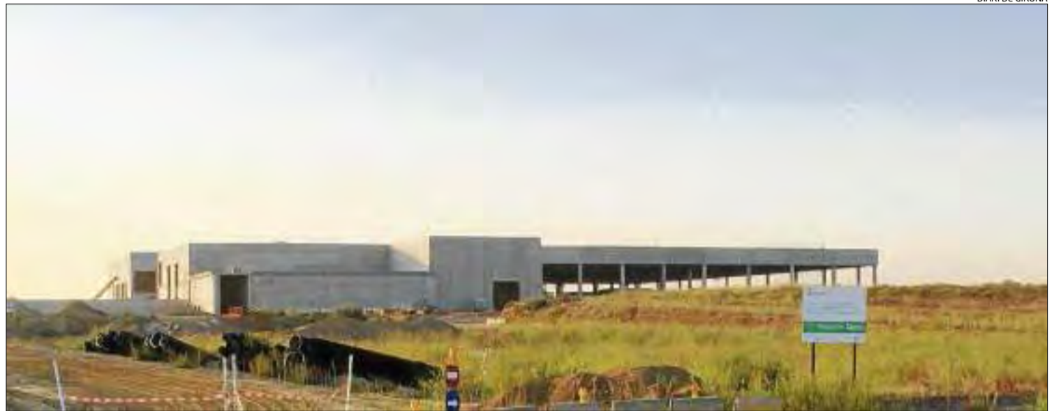
L'estructura del nou equipament, que es va començar a construir l'estiu de l'any passat.
