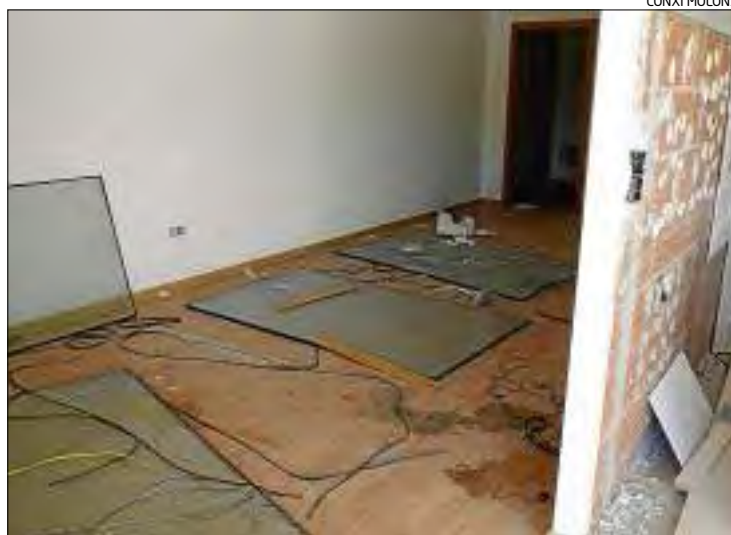
L'edifici del Ponent ha quedat pràcticament amb l'estructura.
