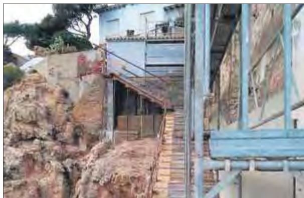
Les obres al tram de l'escala del camí de ronda ■ GDC
