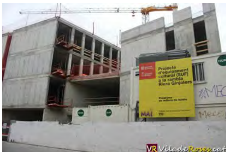
Les obres de l'equipament cultural de la SUF de Roses no avancen al ritme previst
