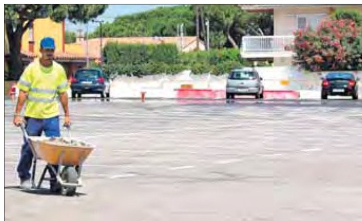
La setmana passada van acabar les obres del pàrquing. BORJA BALSERA
