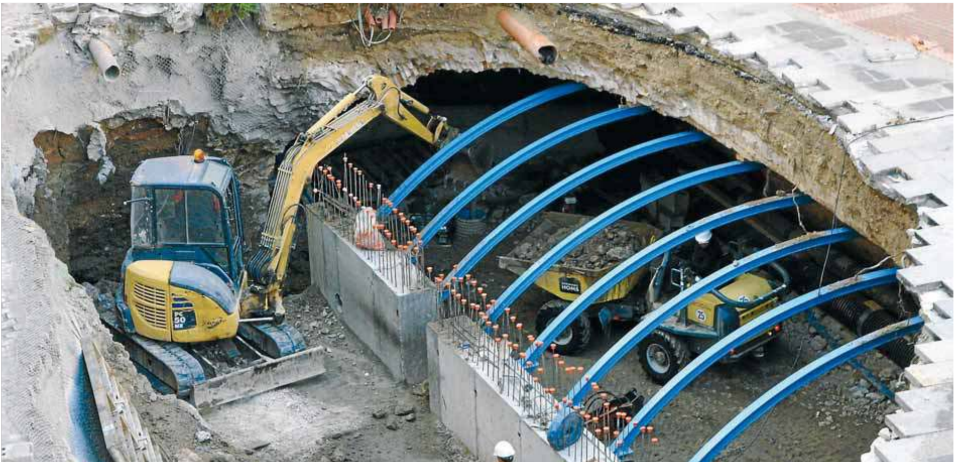
Les obres per reconstruir la Rambla de Figueres han estat un dels temes de l'any a la capital altempordanesa. Les obres, en una imatge de mitjans de gener ■ JOAN SABATER
