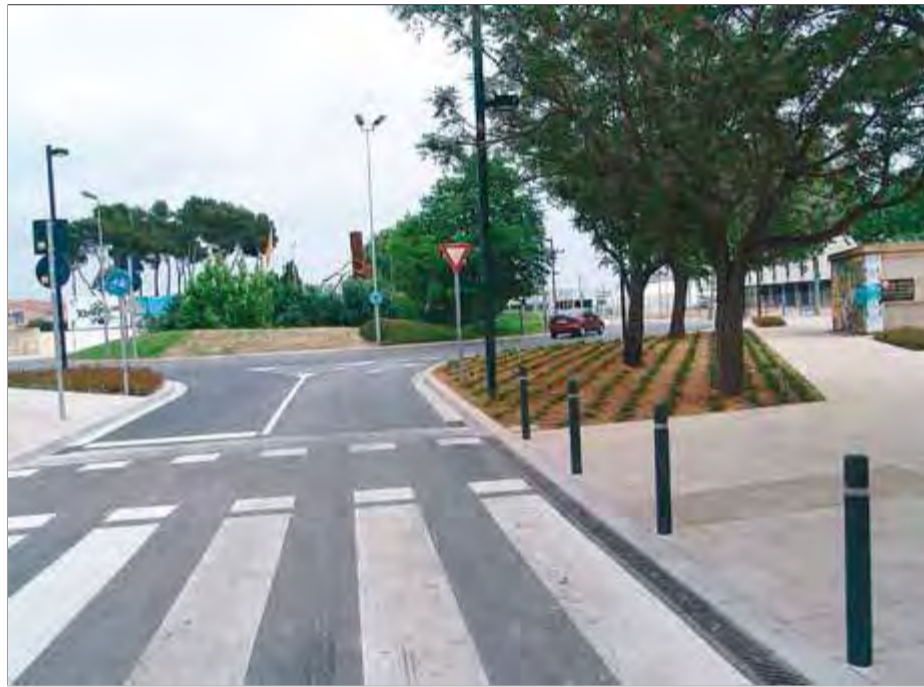
Les obres de l'avinguda Vilallonga de Figueres es van acabar el 2011 però els veïns ara han de pagar l'última quota de les contribucions especials ■ J.P.
