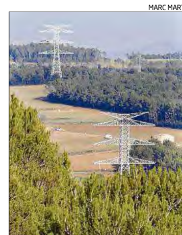
Una torre de la MAT.
