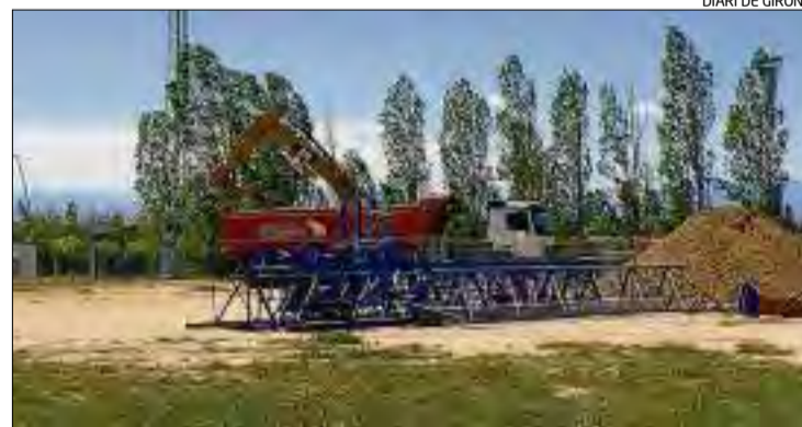
Les màquines, treballant al solar on es construeix el centre.
