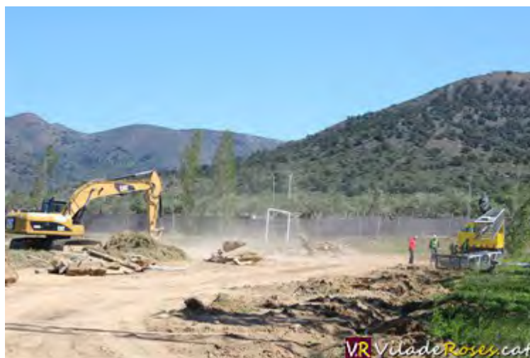
Màquinària treballant en els terrenys on s'ubicarà la nova escola Montserrat Vayreda de Roses
