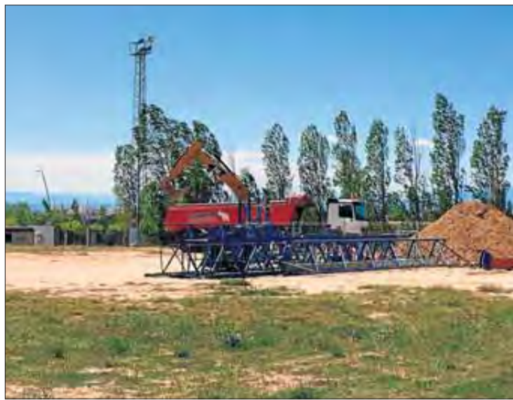
Els treballs s'han iniciat amb l'aplanament del terreny. AJUNTAMENT DE ROSES
