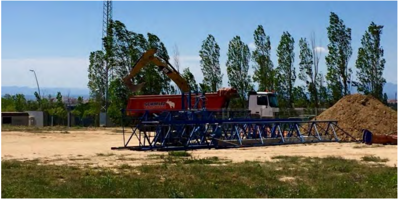
obres per a la construcció de l'escola
