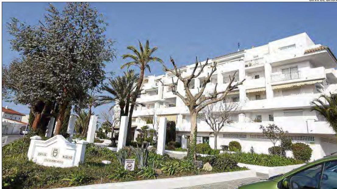
L'edifici del Royal Marine II, amb una sentència que ordena l'enderroc de la quarta planta.
