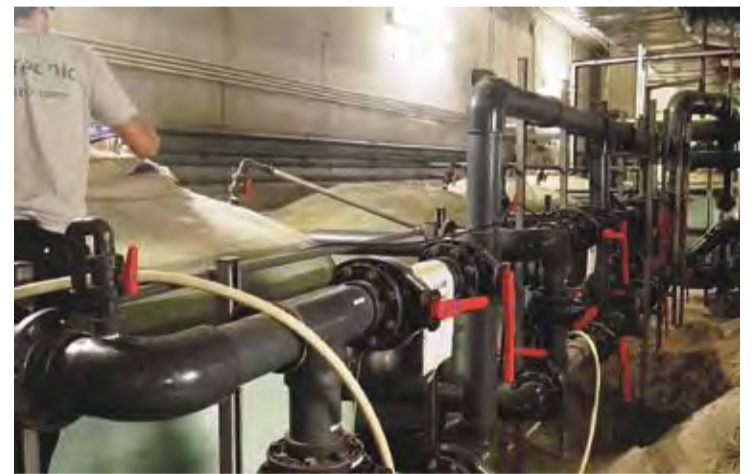
L'ACTUACIÓ. S'ha reposat 17.750 quilos de material filtrant
