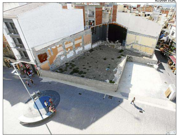
El solar buit després que s'enderroqués l'edifici fa uns mesos.
