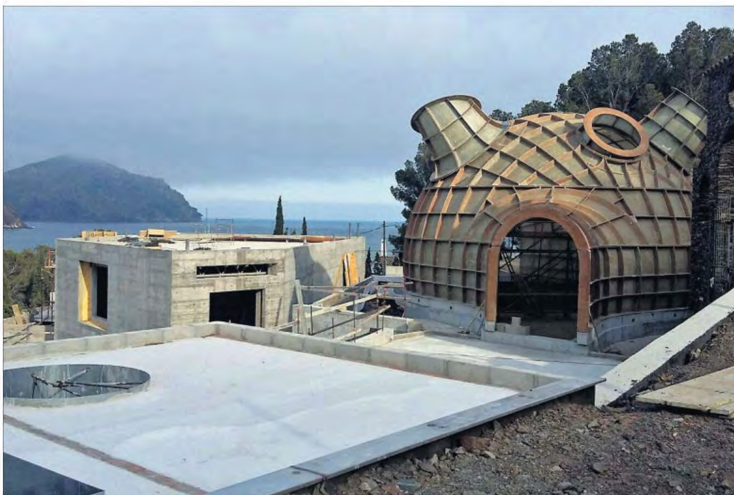
Obras del nuevo centro El Bulli 1846 en Cala Montjoi (Alt Empordà).
