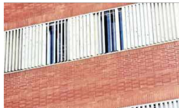
Aspecte de les làmines d'algunes persianes exteriors de la façana, que serveixen per impedir el pas de la llum del sol ■ CCOO TRUETA
