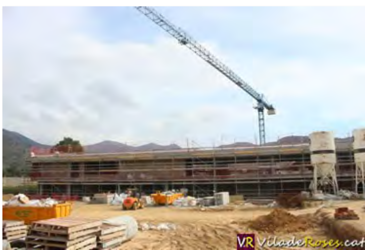
Les obres de la nova escola Montserrat Vayreda aquest matí
