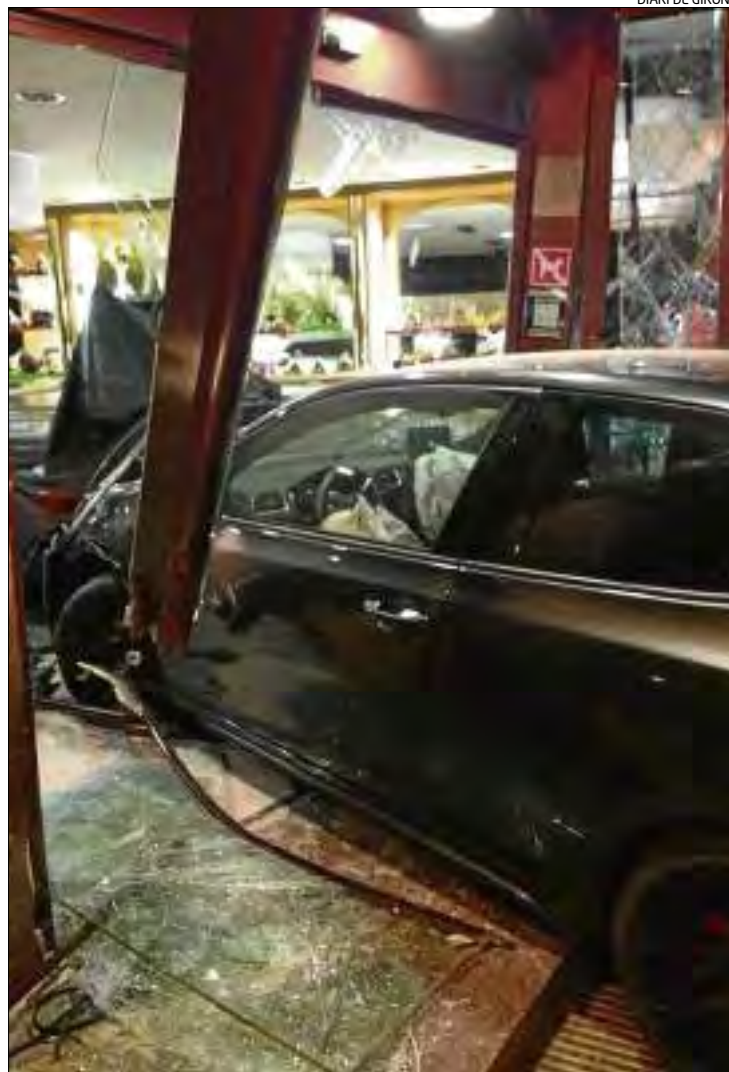
L'automòbil va afectar la porta d'accés i les neveres de l'establiment.
