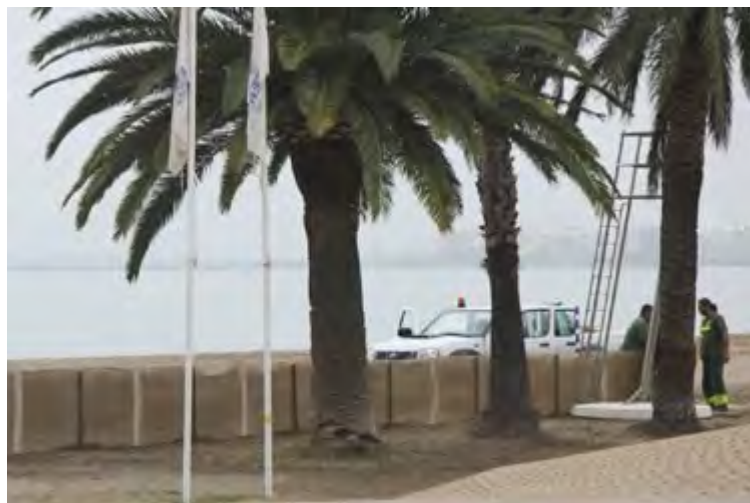
Pantalles protectores col·locades a la platja Nova per evitar la pèrdua de sorra
