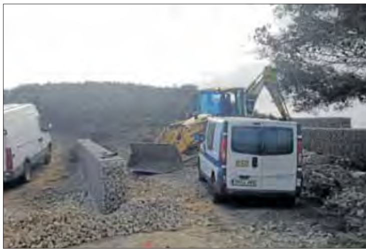
Les obres es fan sobre punta Falconera. AJUNTAMENT DE ROSES
