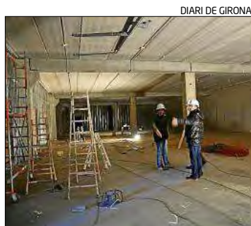
Els treballs que s'hi estan fent.
