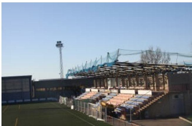
Inicien la substitució de la coberta de l'Estadi Municipal de Roses
