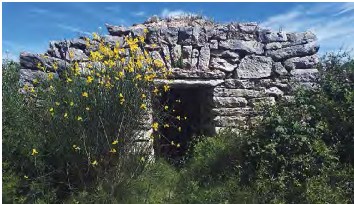
BARRACA. Construcció de pedra seca a la Garriga d'Empordà
