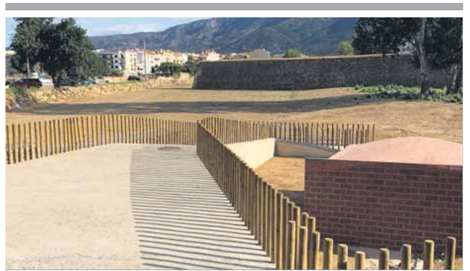
Els últims treballs han posat al descobert un nou tram de la muralla del monument i la font de la Vituà -a la dreta de la imatge-, de la qual només es veia la coberta ■ A.J. ROSES
