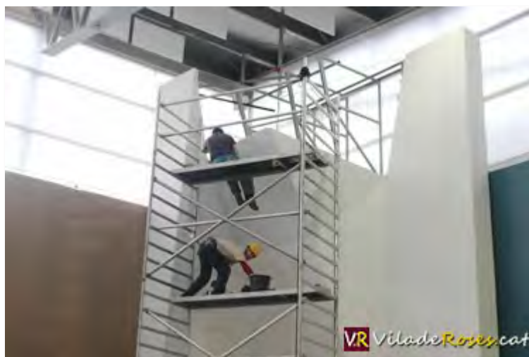
Operaris de Gecko Walls treballant en la part superior de la instal·lació del rocòdrom
