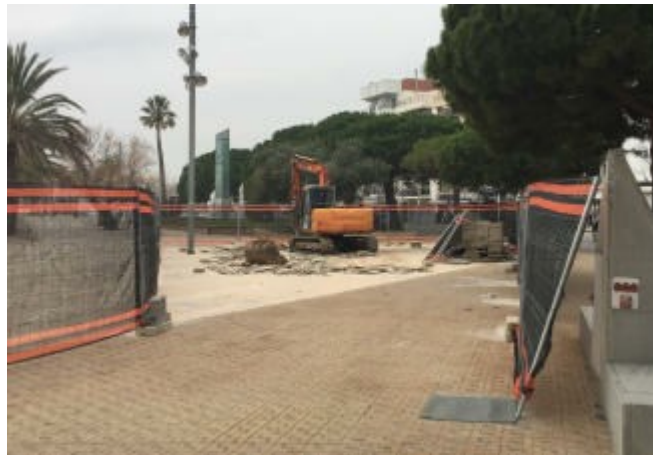
Els treballs acaben de començar AJUNTAMENT DE ROSES
