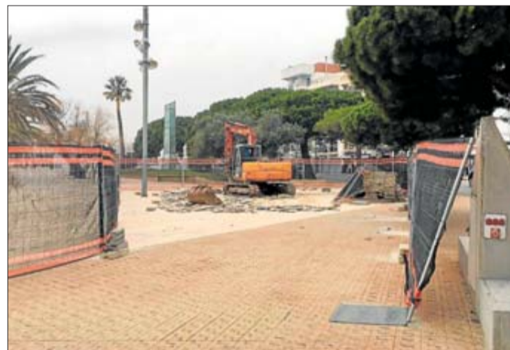
Els treballs que s'estan portant a terme. AJUNTAMENT DE ROSES
