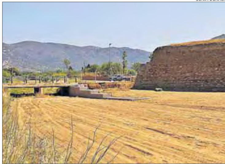
Estat de les obres del marge esquerre de la Ciutadella.
